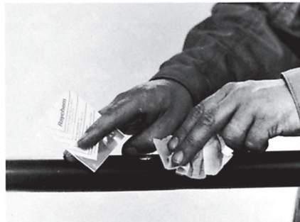
2 Gör ren ca 400 cm av manteln med våtduk och torka efter med torr och ren trasa eller torkduk.
