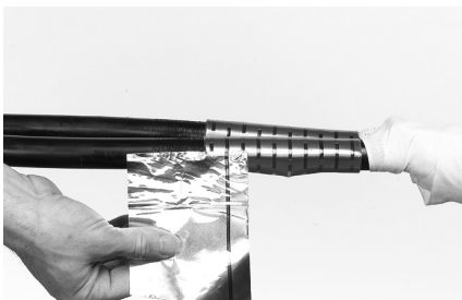
4.7 Vid grenskarv: Placera aluminiumtejpen med den blå linjen över det andra spåret på värmeskyddet, och linda runt kabeln. OBS! Appliceras på alla kablar i grenändan.
